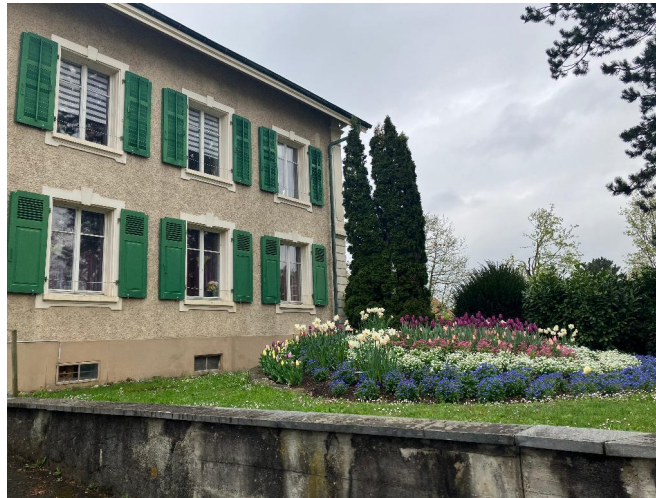
Bestehendes Gebäude Loogstrasse (Parzelle Kat. Nr. 1894)
