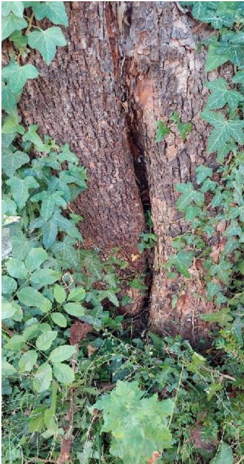
Morscher Riss im Stamm bis zu den Wurzelanläufen.
