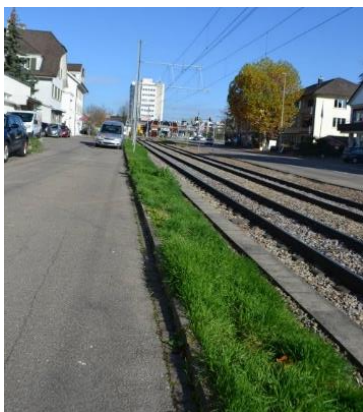
Abb. 9: Sicht auf das Schotter-Trassee der BLT-Tramlinie 10 bei der Emil Frey-Strasse (Quelle: eigene Fotografie).
