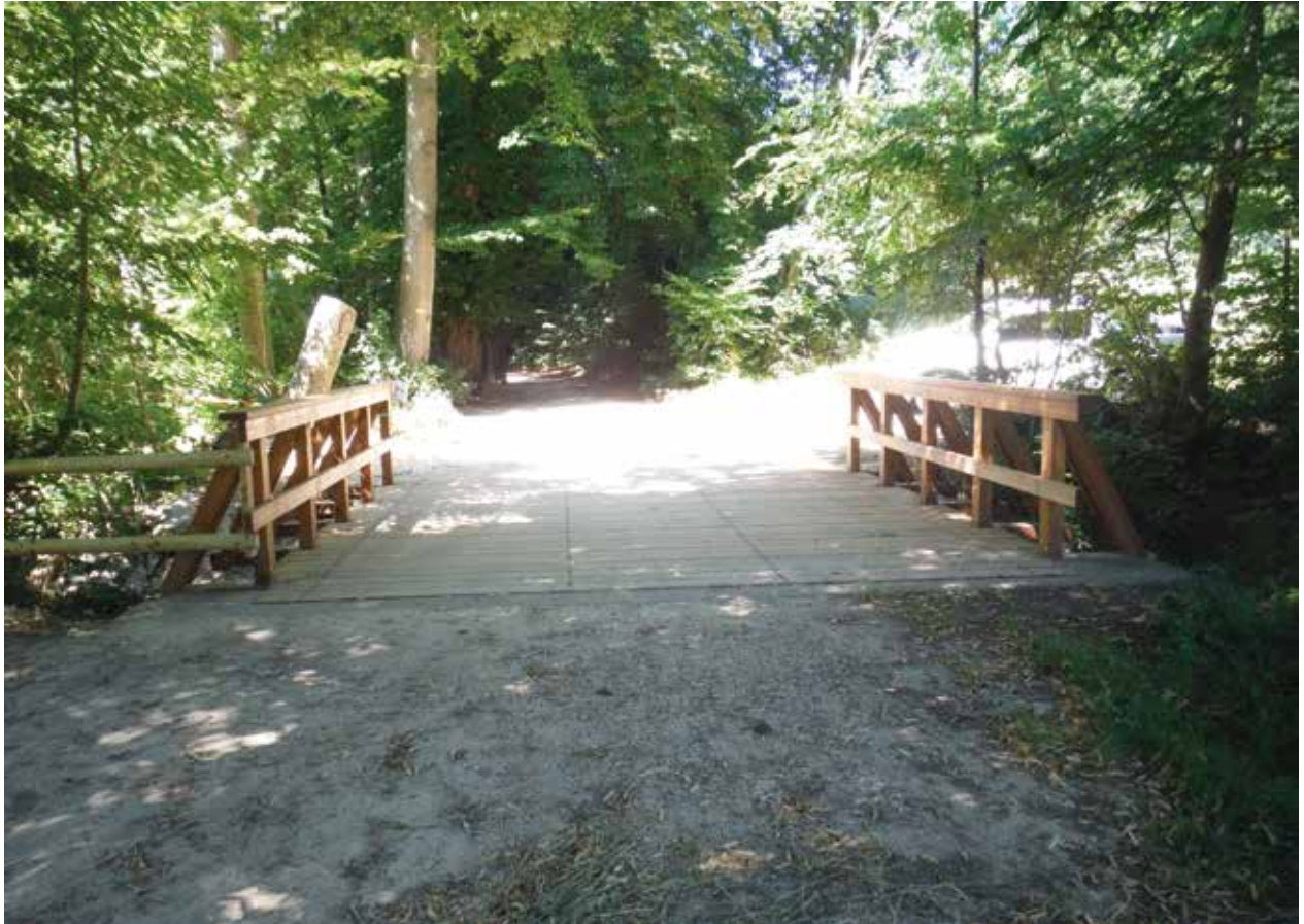
Die neue Holzbrücke in der Däntschi wurde vom Werkhof in Eigenregie gebaut
