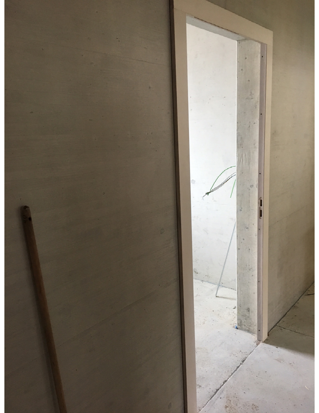
KIGA, 1.OG, Montage Türrahmen
