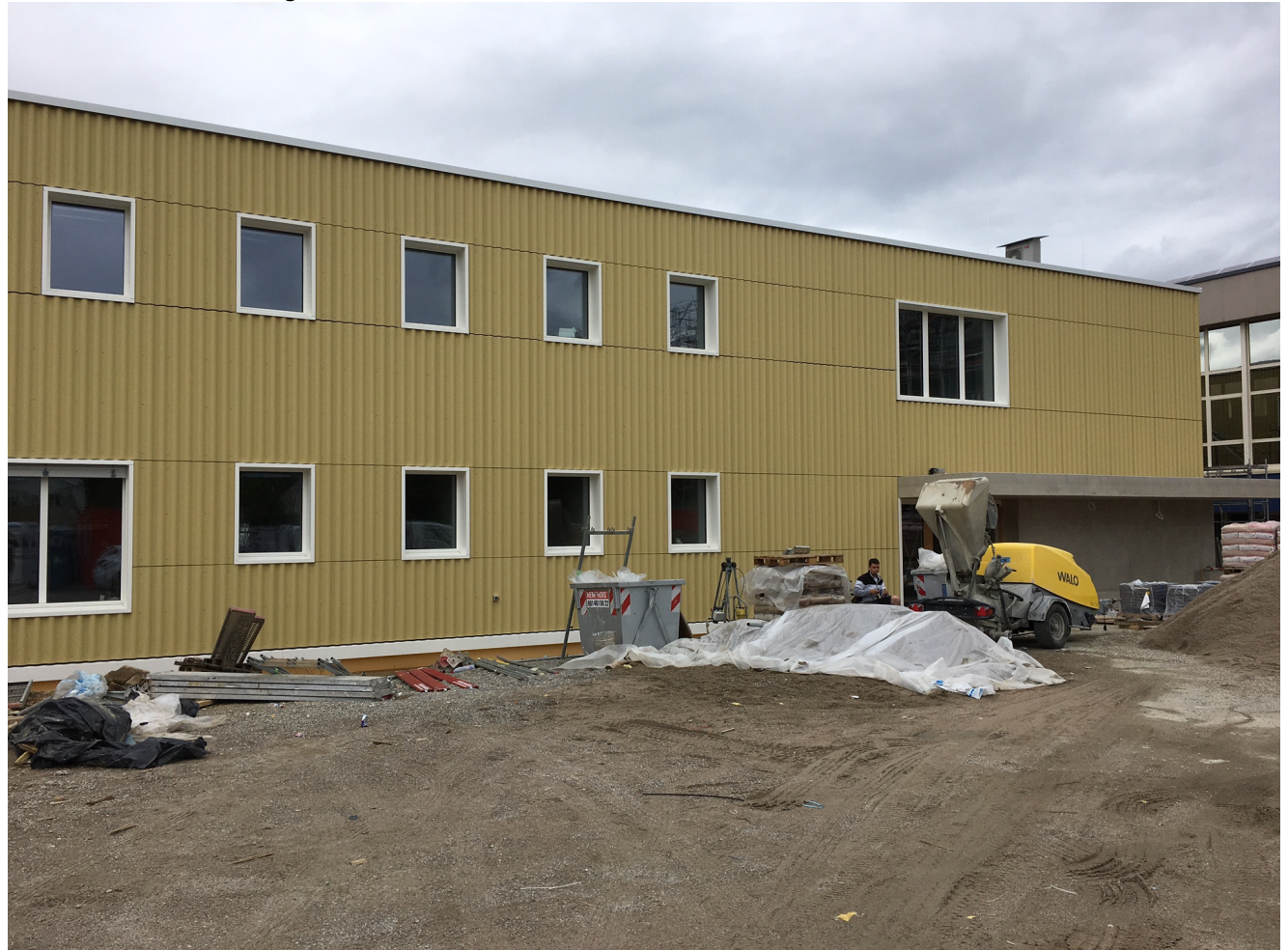
KIGA, Fassade, Demontage Gerüst
